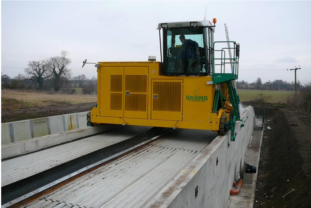
Σχήμα 4: Δυναμική κομποστοποίηση σε τούνελ – άποψη του πιλοτικού χώρου
