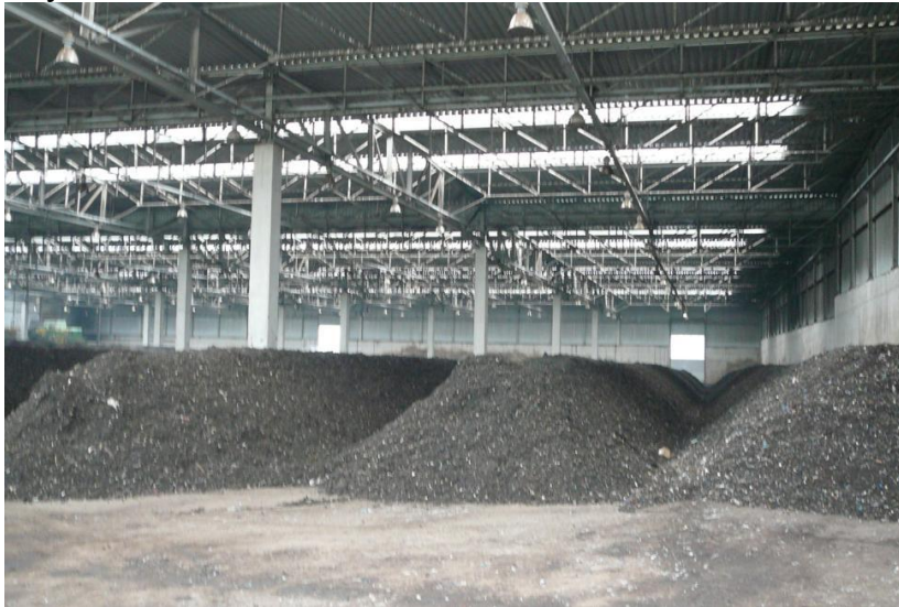
Σχήμα 1: Ωρίμανση στο εργοστάσιο MBT Cröbern μετά την αλλαγή σε τριγωνικούς σωρούς
